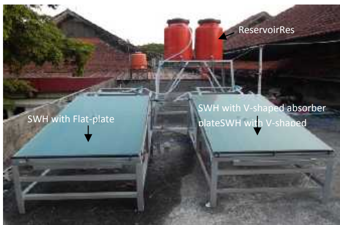
Gambar 4. Sistem pemanas air tenaga matahari dengan :
