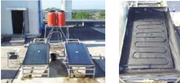
Gambar 5. Sistem pemanas air tenaga matahari model Serpentine
